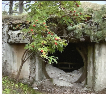
Grefvas bunker är en av de få bunkrar som inte sprängdes. Den var försedd med en 100 mm pansarvärmskanon. Bunkern ligger vid Kustvägen 551 i Degerby.
