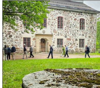
Huvudbyggnaden på Sjunby gård uppfördes 1560 av Jacob Henriksson (Hästesko) och ligger vid Sjundeå forsén. Under Porkalaparentesen fungerade slottet som huvudkvarter för marinbasen.
